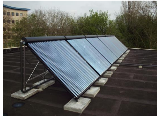
Opstelling heatpipes
