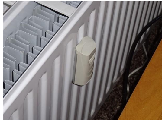
Bemetering warmteafgifte
